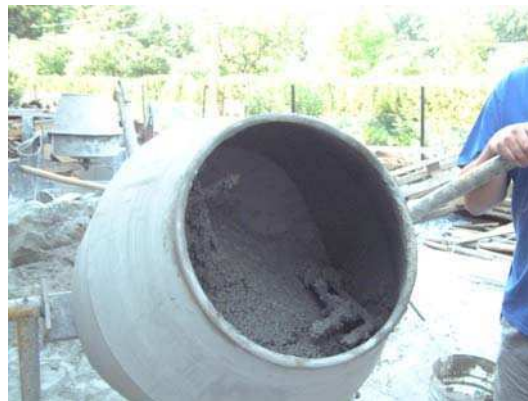
5.1. ábra Könnyű-adalékanyagos beton keverése ejtőkeverőben
