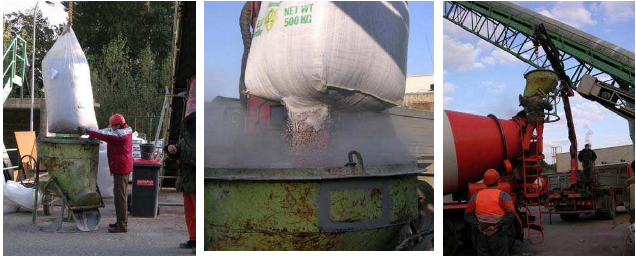
5.2., 5.3., 5.4. ábra Könnyű adalékanyag adagolása a mixerkocsiban lévő habarcszhoz (Readymix, Klosterneuburg)
