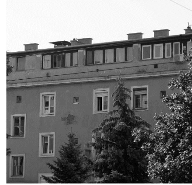
TETŐTÉR BEÉPÍTÉS / VILLÁNYI ÚT 18.
